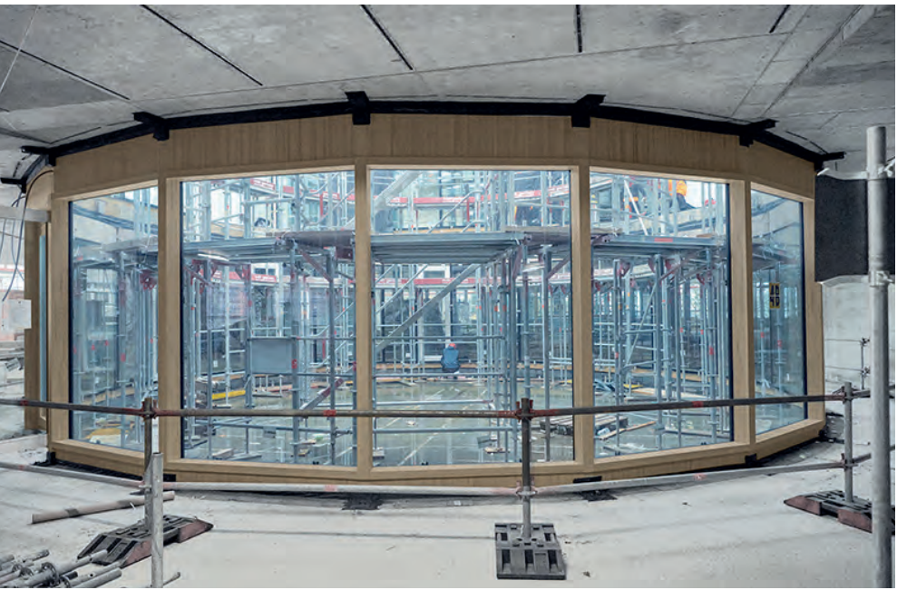
Les cours intérieures fermées ont été dotées de cadres dans la variante bois-bois – plutôt inhabituelle de nos jours – avec des vitres de grand format.
