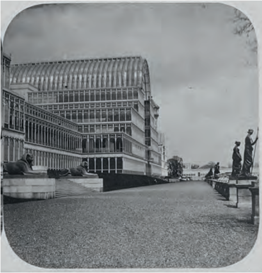
Industrialisation des vitraux : le Crystal Palace destiné à la première exposition universelle de Londres en 1851, et conçu par Joseph Paxton, est un prototype de préfabrication. Jusqu'alors, jamais encore d'aussi grandes surfaces vitrées d'un seul tenant n'avaient été produites.
