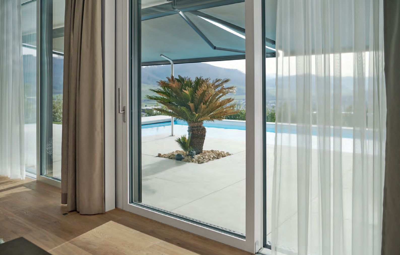
Le système de façade Synfinity a permis d'assembler les portes coulissantes et les fenêtres à battants en bandes de fenêtres continues de la hauteur d'un étage.
