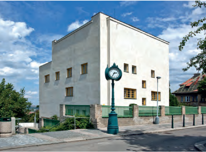
Bandeau de fenêtres ou fenêtres à trous : parmi les architectes du mouvement moderne, le débat a toujours persisté à ce sujet. Photo de gauche : maison Müller à Prague d'Adolf Loos (1928-30). Photo de droite : villa sur le Weissenhof de Le Corbusier et P. Jeanneret (1928) (les deux images Creative Commons BY 3.0).
