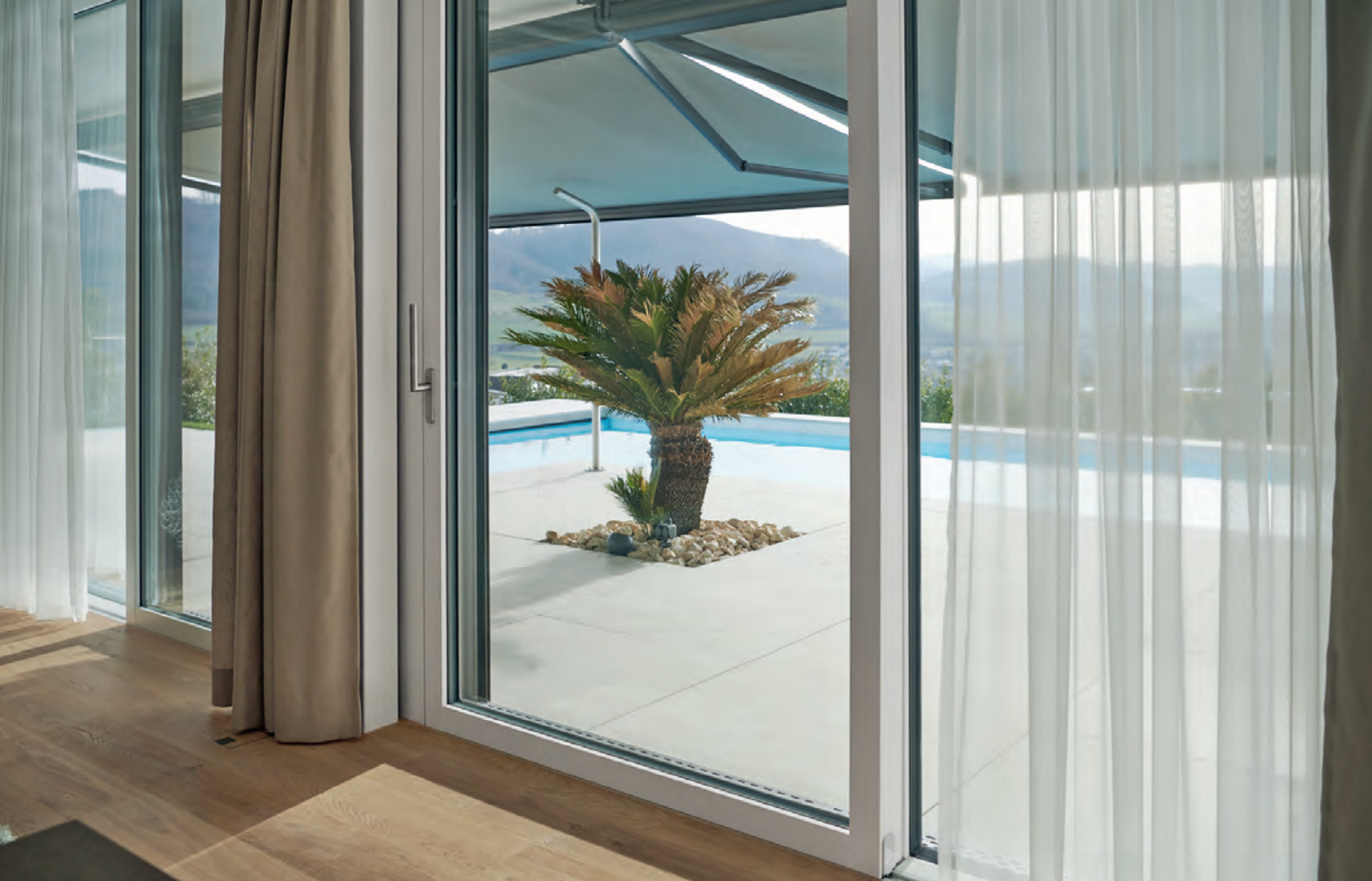
Das Fassadensystem Synfinity ermöglichte es, die Schiebetüren und Flügelfenster zu geschosshohen Fensterbändern ohne Unterbruch zusammenzufügen.
