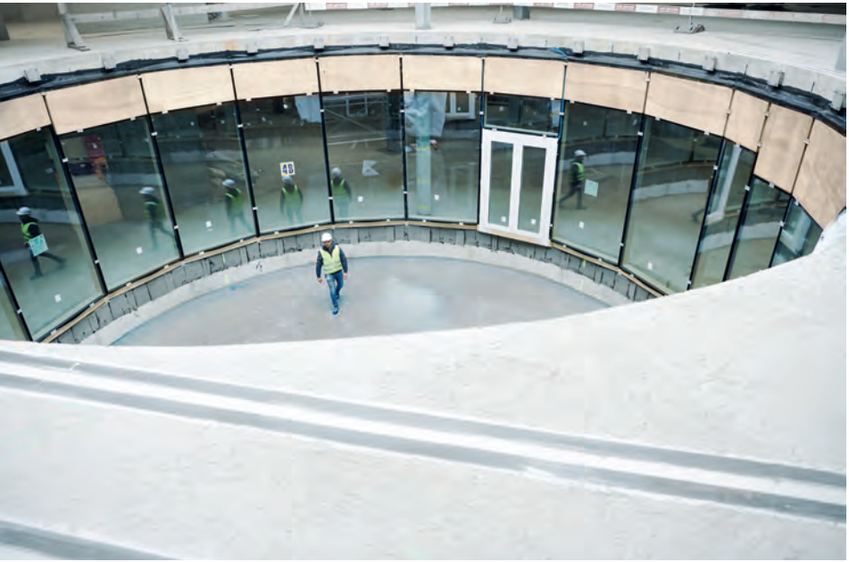
Die abgeschlossenen Innenhöfe erhielten Rahmen in der – heute eher ungewöhnlichen – Variante Holz/Holz mit grossformatigen Glasscheiben.
