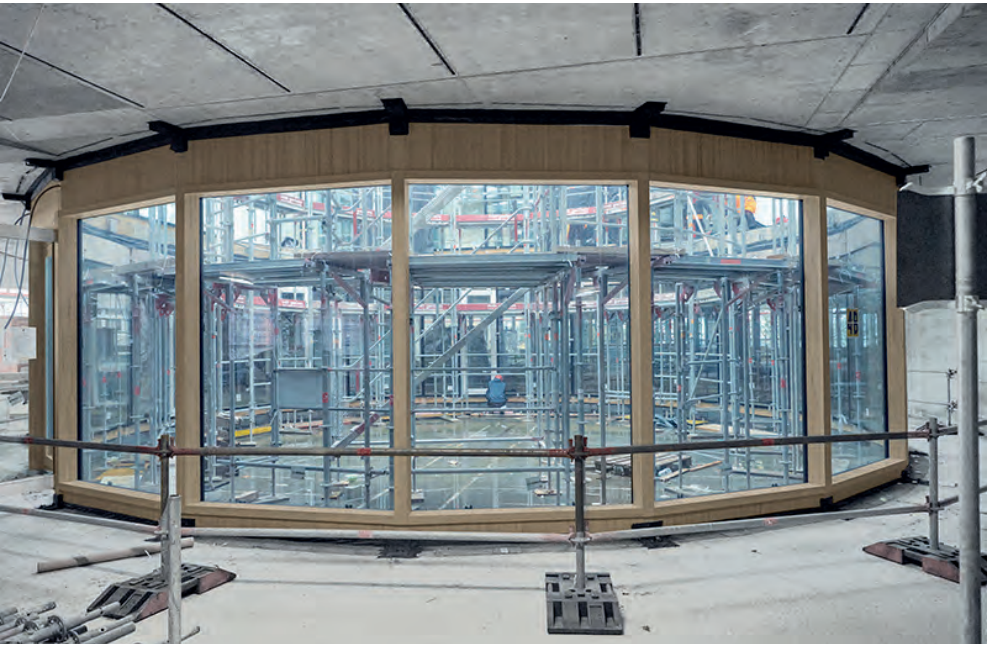
Die abgeschlossenen Innenhöfe erhielten Rahmen in der – heute eher ungewöhnlichen – Variante Holz/Holz mit grossformatigen Glasscheiben.
