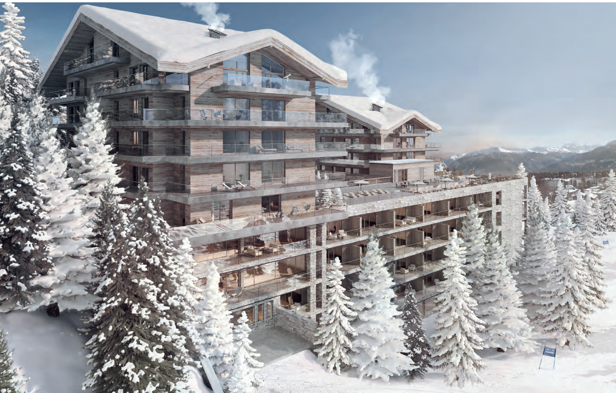
Der Respekt gegenüber der Natur ist bestimmend in der Architektur des neuen Six Senses Resorts in Crans-Montana. Dank den grossflächigen Fenstern und Schiebetüren von 4B verschmelzen alle Räume mit dem einzigartigen Landschaftsraum der Walliser Bergwelt.
