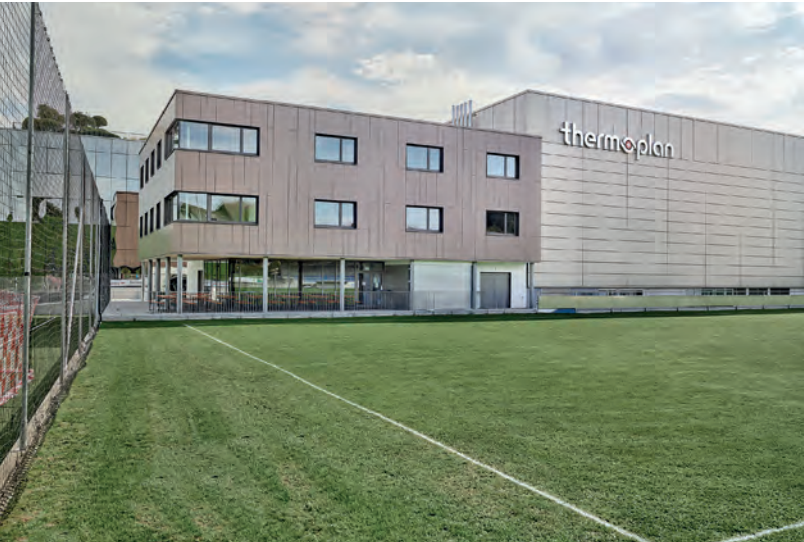
Eine eigenständige und zugleich gut integrierte Lösung: Beim Clubhaus sind die Pfosten-Riegel-Glasfassade im Erdgeschoss und eine hinterlüftete Fassade aus Blech und Trespa-Platten in Kombination mit Kunststofffenstern von 4B perfekt aufeinander abgestimmt.
