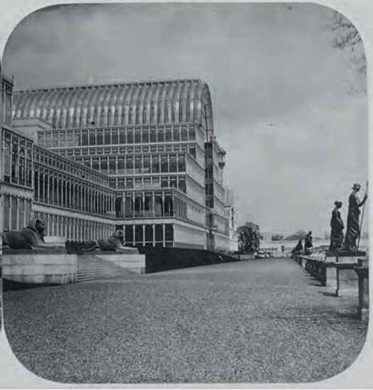
Industrialisierung von Glasfenstern: Der Crystal Palace für die erste Weltausstellung in London 1851 von Joseph Paxton ist ein Prototyp der Vorfabrikation. Bis dahin waren noch nie so grosse zusammenhängende Fensterflächen produziert worden.
