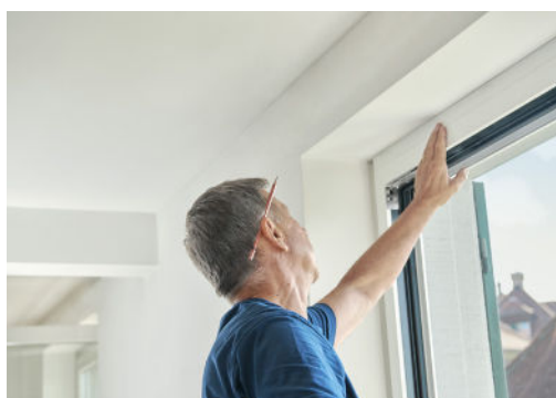
Montage eines neuen Fensterrahmens
